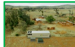
図-5b：MDCは、セキュリティ機能を備えており、コンテナ単体でデータセンターとして機能可能 (Credit: Microsoft)[NO.086]
